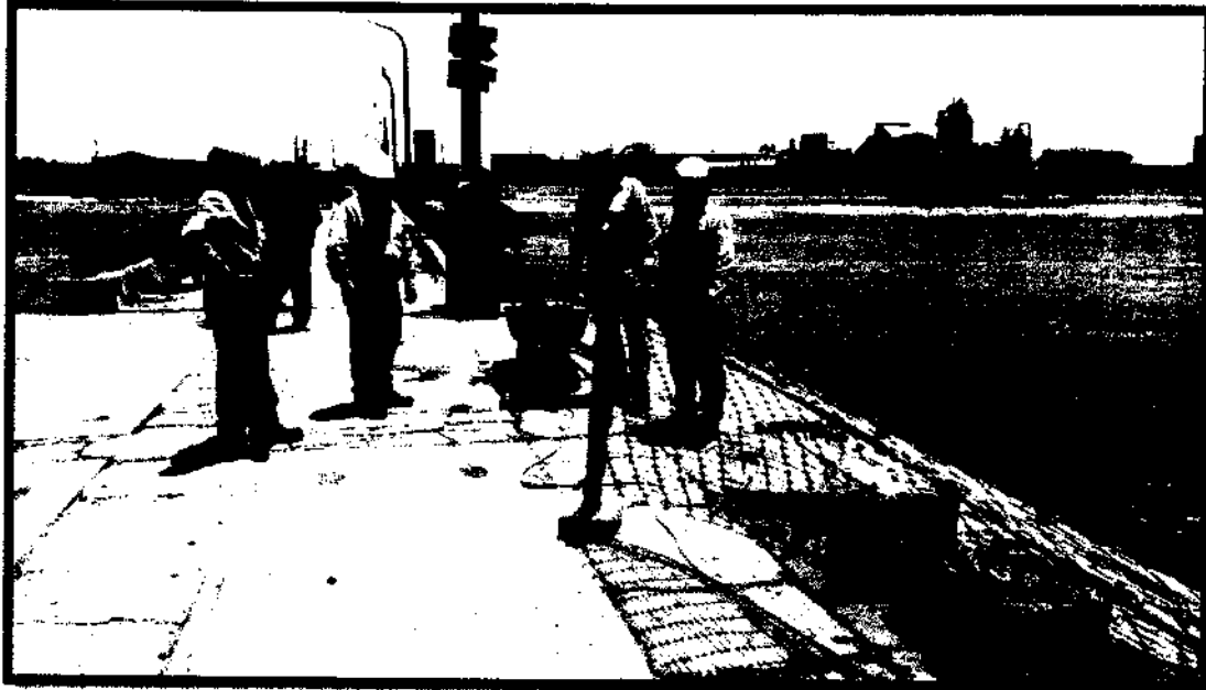
FOTO N°09: SE OBSERVA AL PLANTEL TECNICO DE LA EMPRESA Y LA SUPERVISION PONIENDOSE DE ACUERDO AL TRABAJO A REALIZAR.
