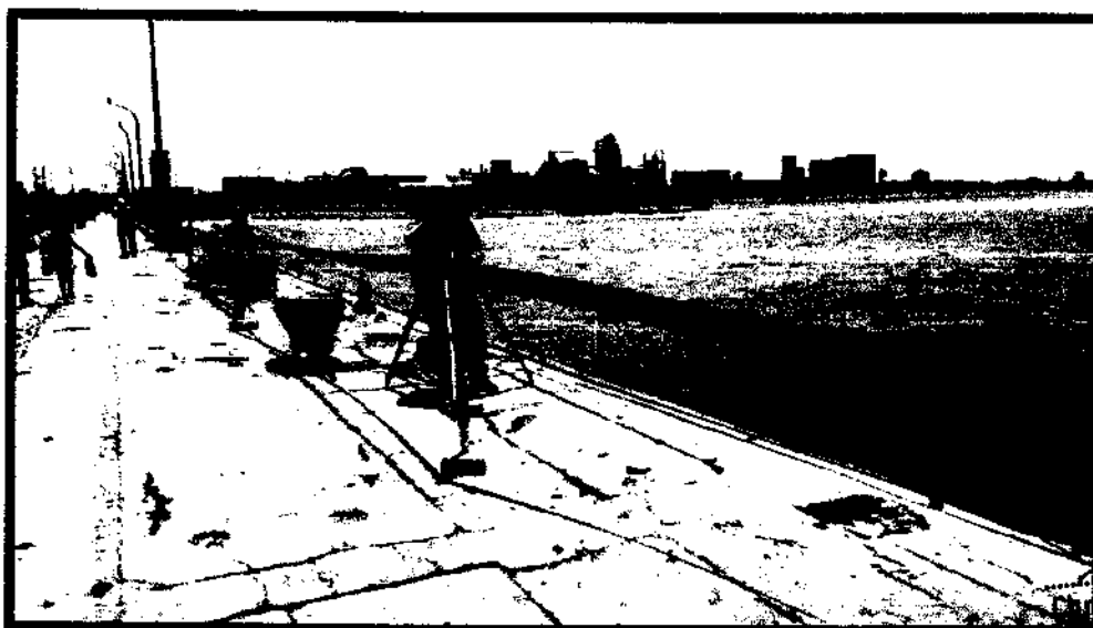
FOTO N°07: SE OBSERVA AL TRABAJADOR REALIZANDO EL PERFORADO PARA EL PEDESTAL. USO DE EPP's.
