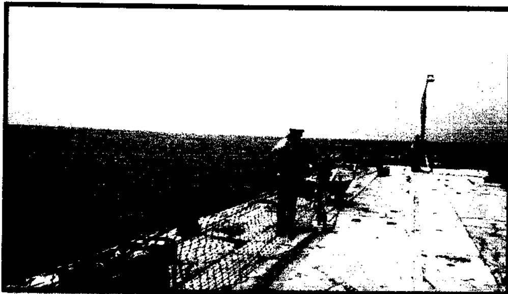
FOTO N°19: SE VISUALIZA AL ASISTENTE DE SEGURIDAD QUE SE ENMALLO, EL AREA DE TRABAJO ANTES DE COMENZAR LA LABOR EN LA LOSA DEL MUELLE.
